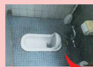
工事前 （元々は男性専用トイレ）
